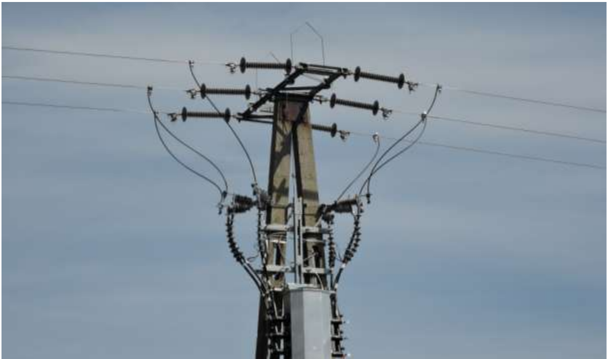
6. kép: Az NKM Áramhálózati Kft. szolgáltatási területén felszerelt első 800mm hosszú feszítőszigetelő-sor a Baksi-pusztán
