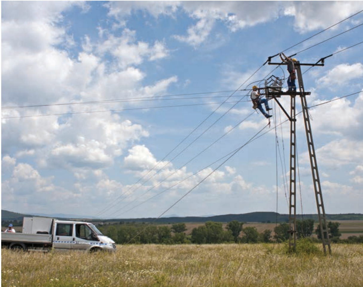
2. ábra: A háromfázisú tartó-leágazó oszlop a leágazásban kapcsolóval, amelyen a parlagi sas ( Aquila heliaca ) pár hónappal a madárbaráttá alakítás után áramütés érte (fotó: Kovács András) / The three-phase pole with a mounted switch which killed an Eastern Imperial Eagle soon after retrofitting
