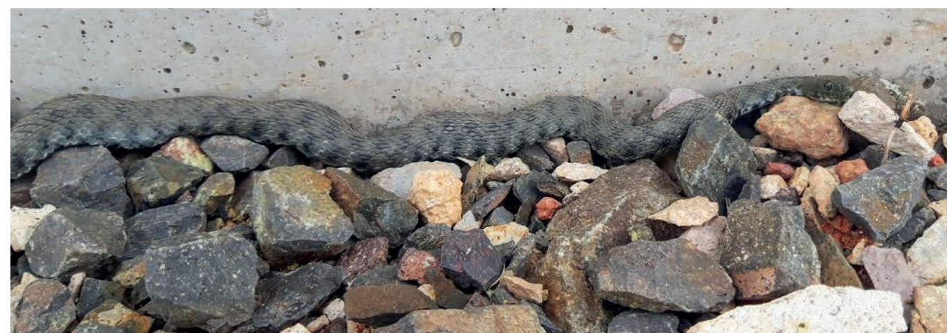
↑↑ Betongát a Zagyván (fotó: Fábíán Zoltán)
