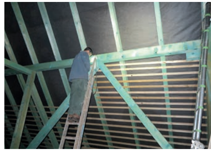
Izsó Ádám a párazáró fólia eltakarását, vagyis a kapaszkodóhelyeket is biztosító lécborítás kialakítását végzi egy kiemelkedő denevérszálláson
