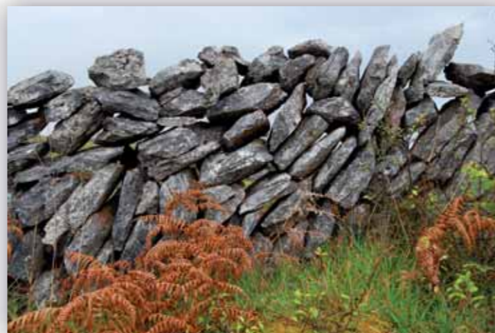
„Csak szellősen” (szárazon rakott kőkerítés, Írország)
