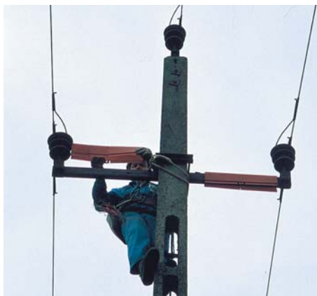
26. fotó: Szigetelő papucs felhelyezése tartóoszlopra (Fotó: Bagyura János).
