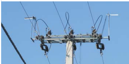
34. fotó: Madarak számára létesített kiülöhely oszlopkapcsolón (Fotó:EDF-DÉMÁSZ).
