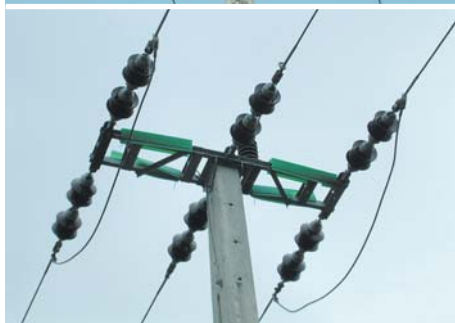
27-29. fotó: Példák a szigetelő papucsok helytelen használatára (Fotó: Demeter Iván).
