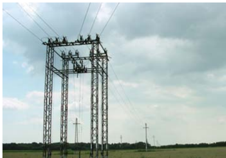
4. fotó: A nyílt élőhelyen futó vezetékcszakaszok kapcsoló-, vagy feszítő-fejszerkezetű oszlopai jelentik a legnagyobb veszélyt a madarakra (Fotó: Demeter Iván).
