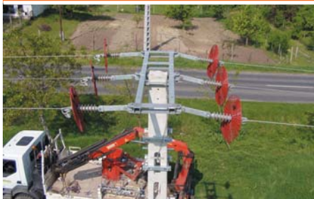
33. fotó: Terelőlemez szerelése feszítőoszlopra (Fotó:EDF-DÉMÁSZ).
