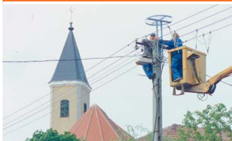
25. fotó: Gólyafészkek-magasító felhelyezése (Fotó: Lovászi Péter).
