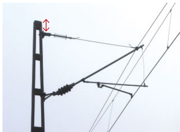
5. ábra: Nem megfelelő méretezésű oszlop (fotó: Tóth Péter) / Inadequately sized pole
