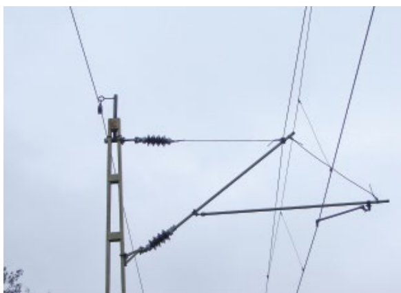
3. ábra: „T” típusú oszlop és tartószerkezete (fotó: Tóth Péter) / T-type pole and its head configuration
