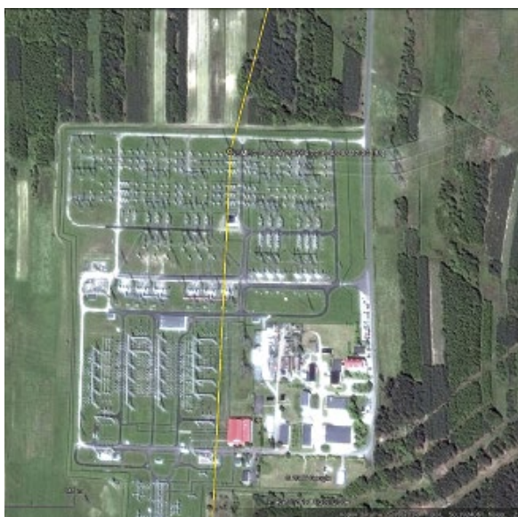
7. ábra: Egyik lengyelországi pihenőhelye a kézrekerülése előtti napokból - egy transzformátor állomás / A transformer station used as a roosting place in Poland a few days before being captured
